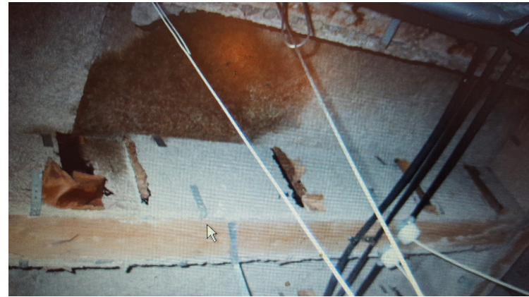
Ceiling void above ICU
